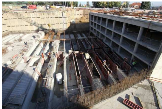
Obr. 1 Globální model jednoho dilatačního úseku PG a výstavba trémového stropu.
