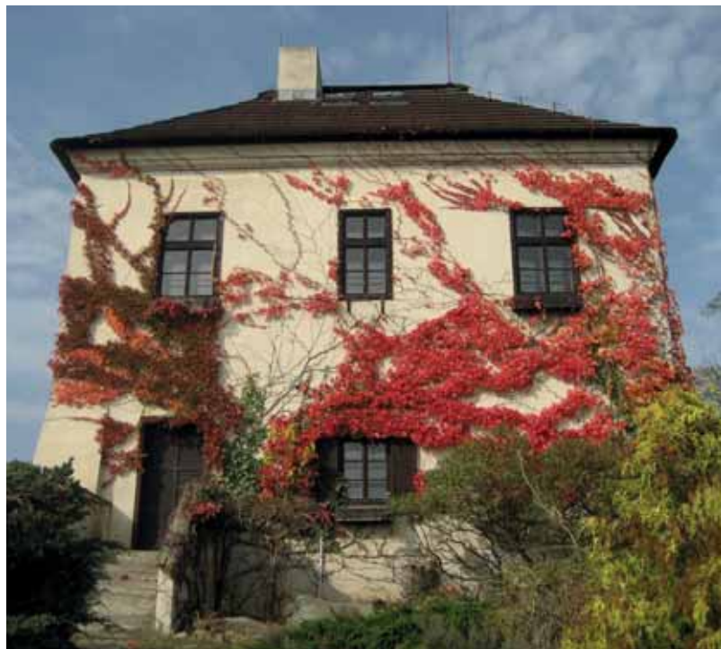
Historická usedlost Sklenářka Praha, stavebně technický průzkum
