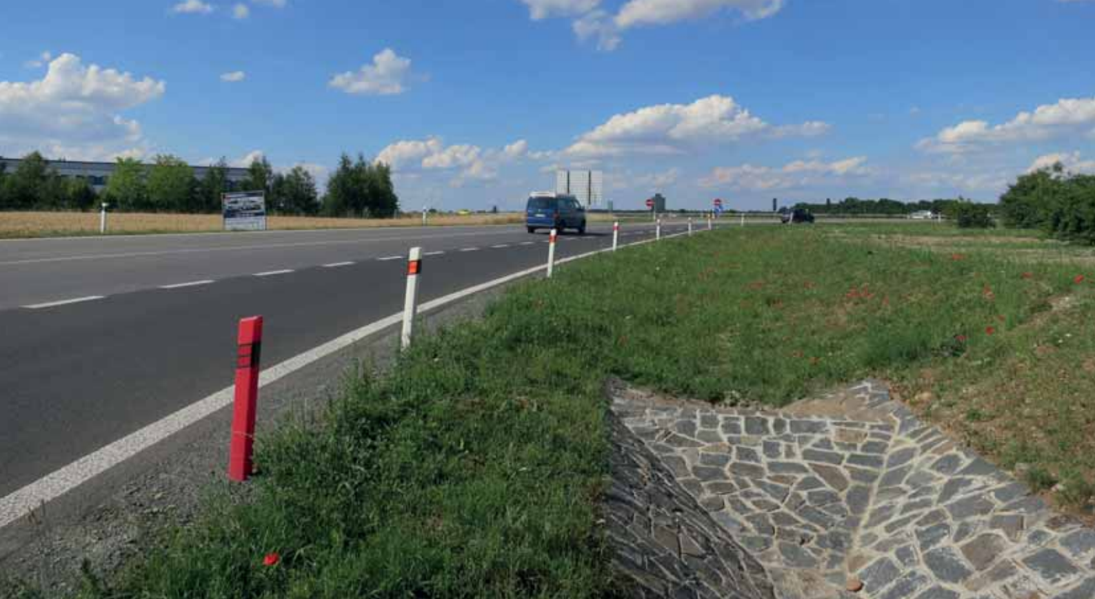
Zdiby – bypass, zajištění stavebního povolení
