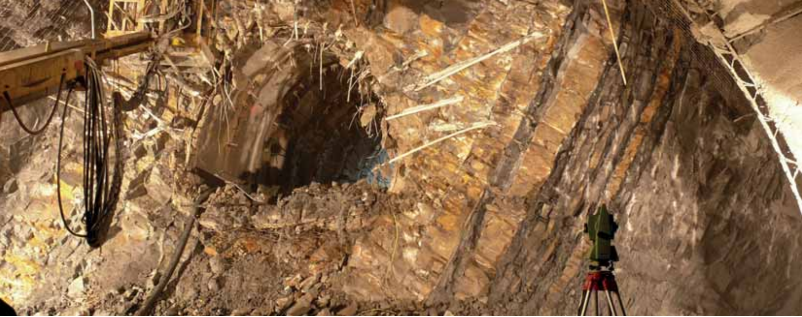
Tunely Blanka, geologické sledování ražeb
