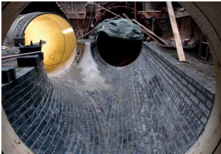
Městský okruh Prahy, spojná komora stok DN 1600
