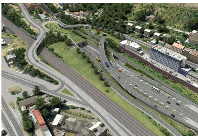
(Obr. 4 Východní portál tunelu Radlice a most na rampě I)
