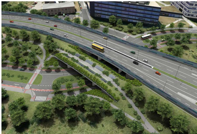
(Obr. 6 Most a biokoridor přes tzv. Novou Radlickou ulici)
