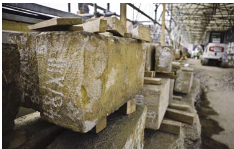
▼ Vyjmuté kvádry pískovce jsou označeny, očištěny a podle míry opotřebování buď vyměněny za nové, nebo navraceny na původní místo
