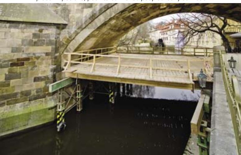
▼ Pro komplexní diagnostiku oblouku nad Čertovkou byla postavena těžká pracovní podlaha, pod kterou mohou podplouvat výletní lodě
