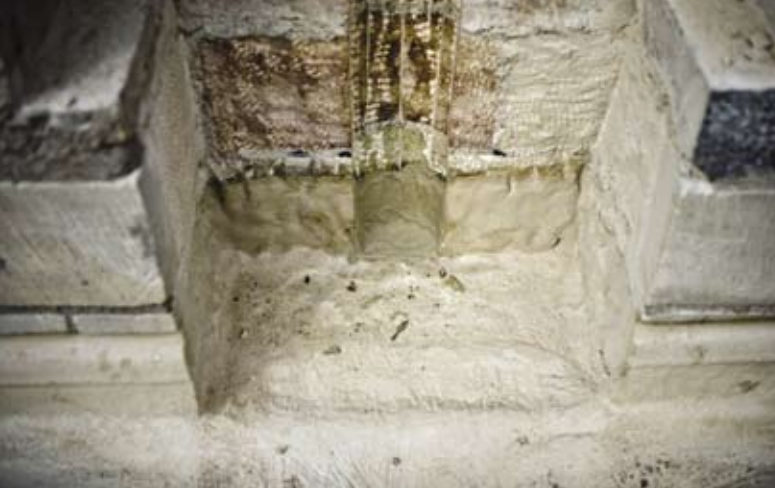
▲ Detail opravené části zábradlí připraveného pro osazení osvětlení mostu
