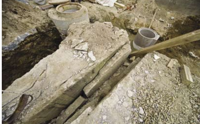
▲ Odvodnění předpolí mostu na Malé Straně
