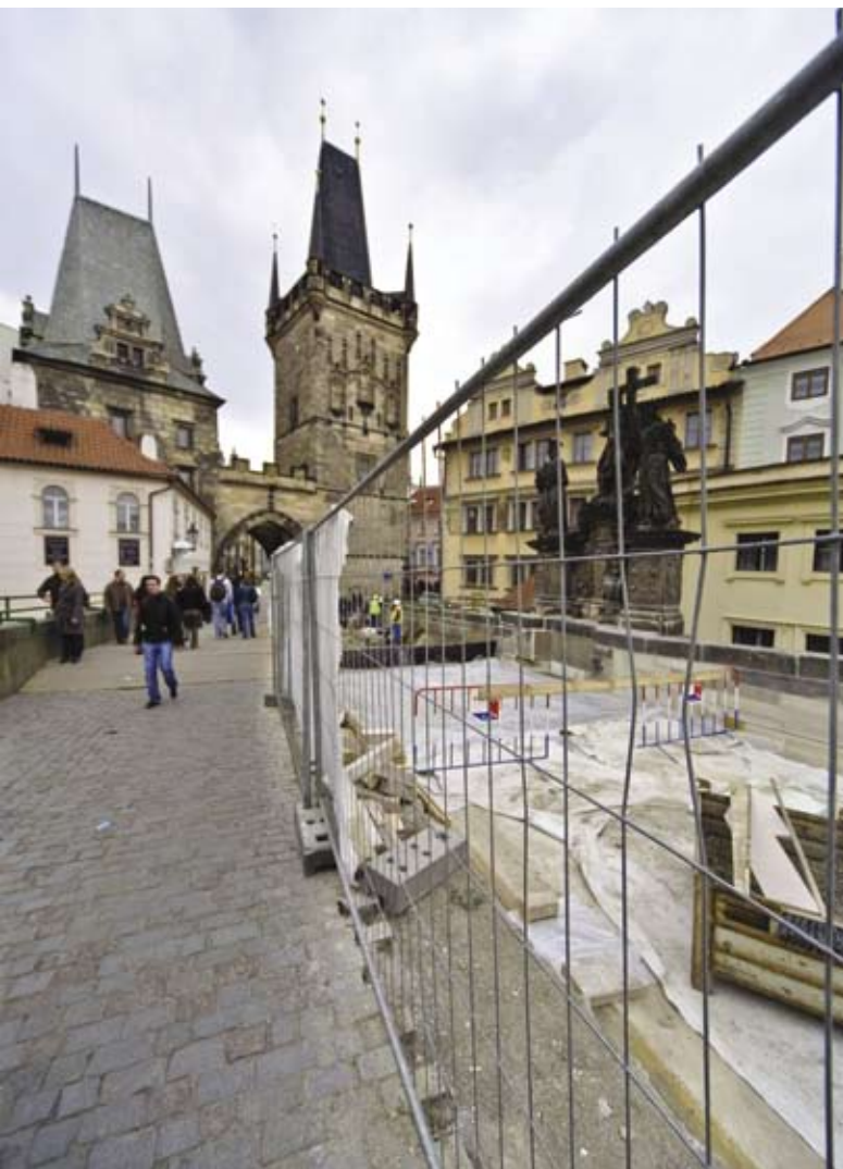
▲ Práce postupují proudově v polovině mostu směrem od Malé Strany
