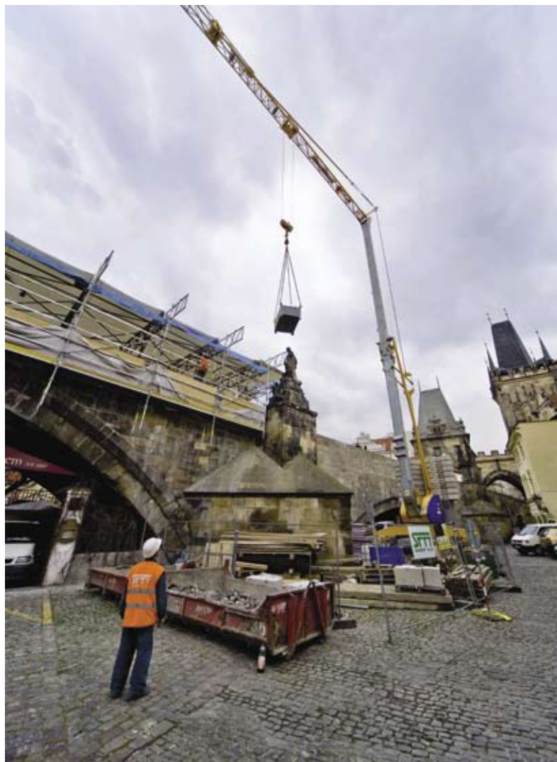
▲ Odebraný materiál je z mostu jeřábem přepravován na břeh Čertovky a dále transportován do deponie
