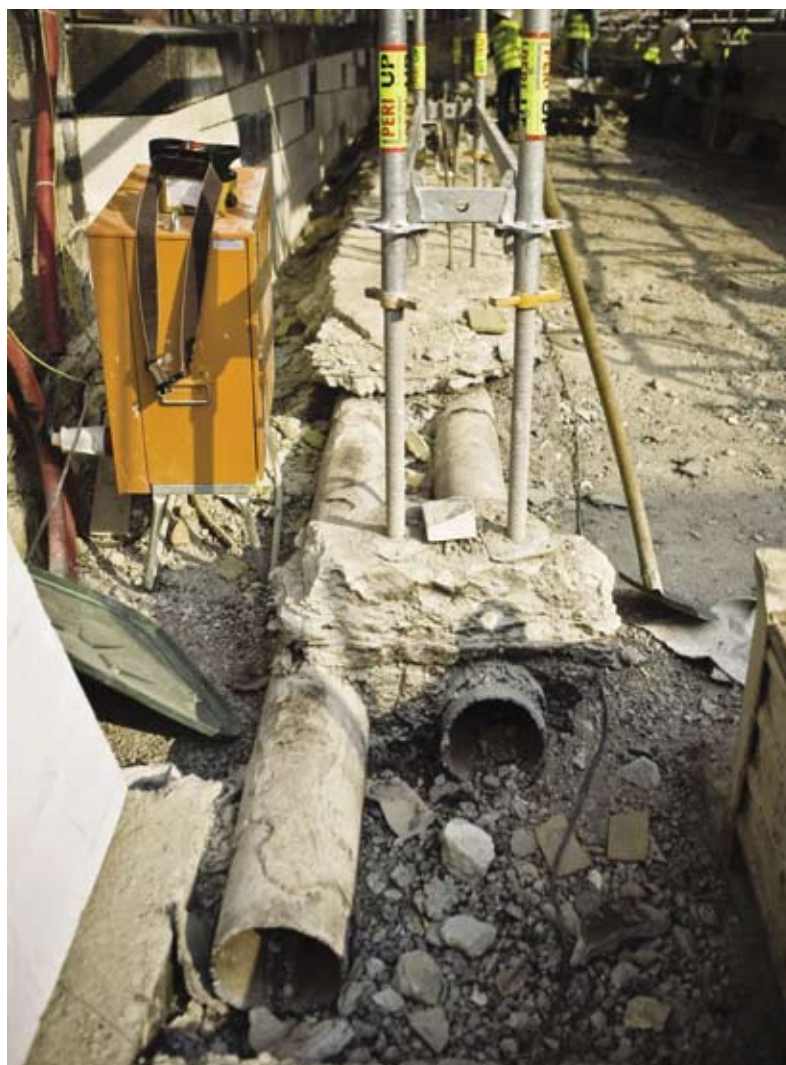
▲ Vyměňovaný trubní systém povrchové vody
