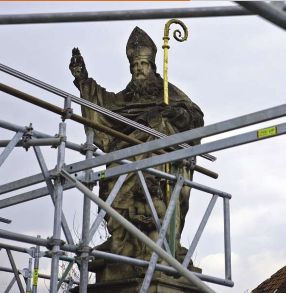
▲ Rekonstrukce Karlova mostu probíhá proudovou metodou, lešení podél barokní výzdoby se posouvá podle harmonogramu stavby
