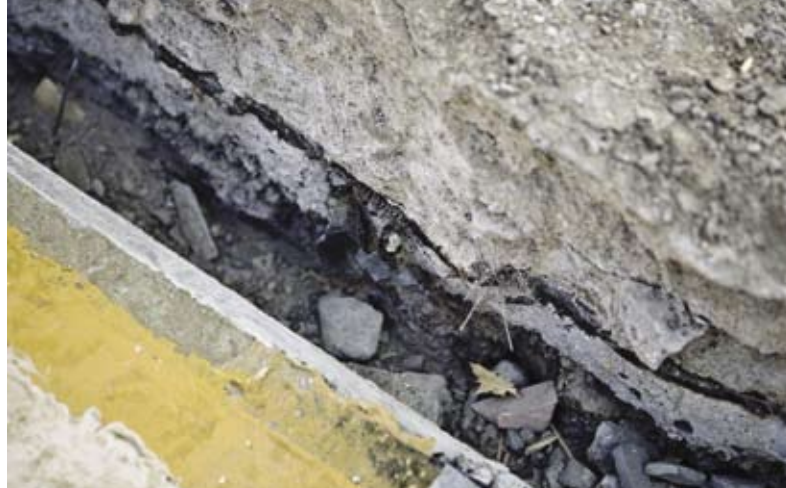
▲ Detail nové těsnicí vrstvy vozovky
