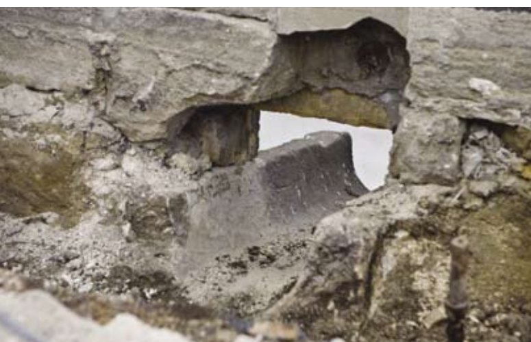
▼ Kamenný chrlič v zábradlí mostu
