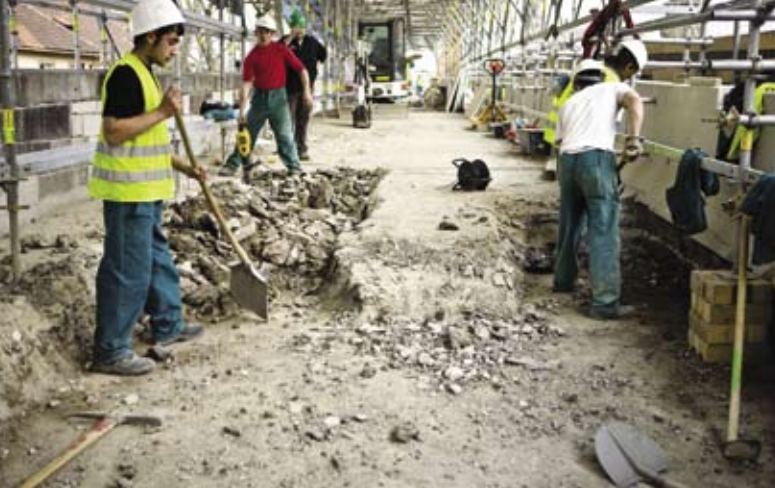
▲ Postupné rozebírání a odstraňování stávajících vrstev vozovky
