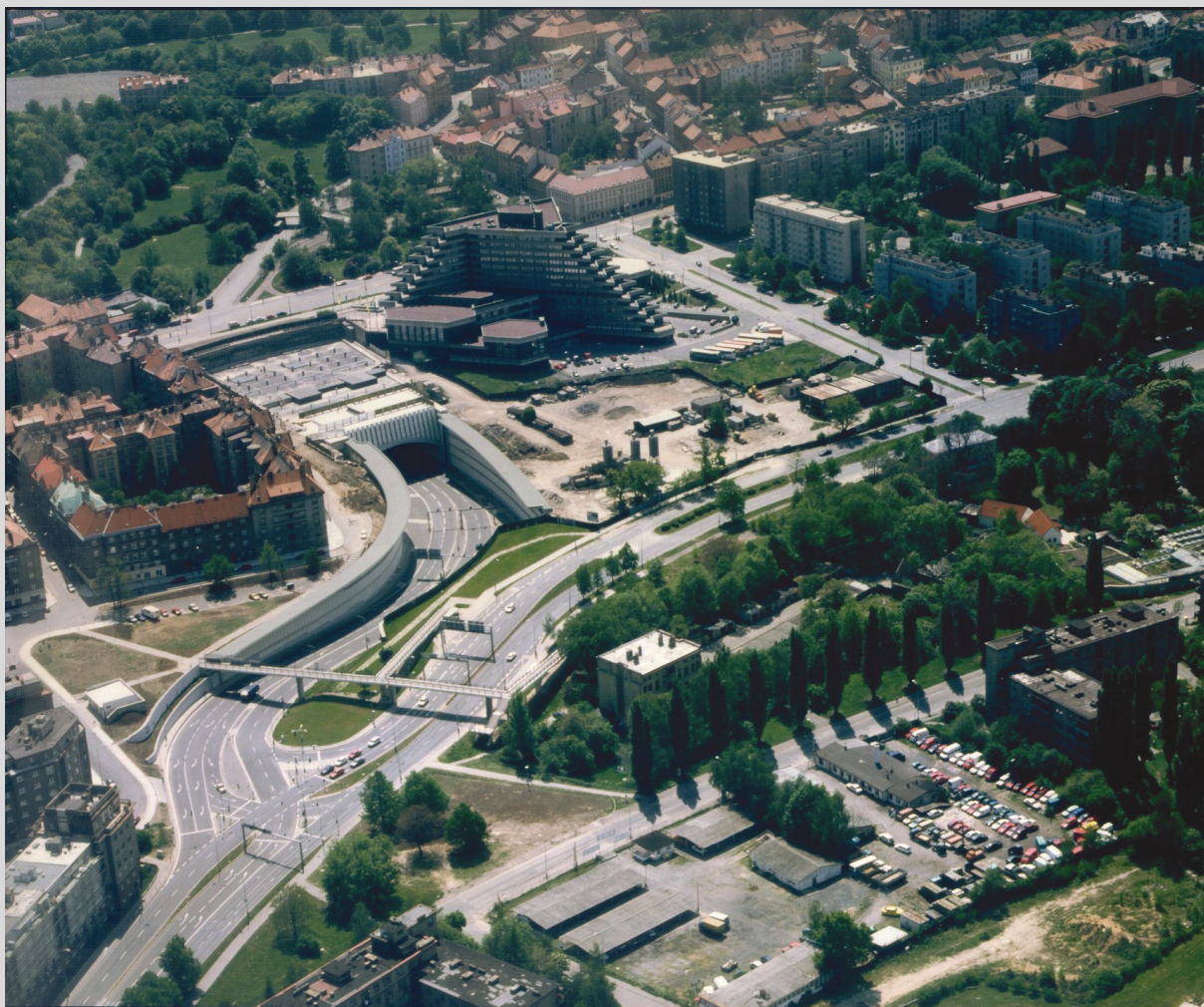
Severní portál Strahovského tunelu
